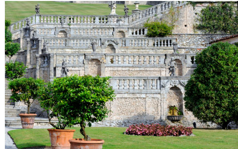
Fig. 7. Villa della Porta Bozzolo, Casalzugno, Garden, 1720s, terraces. (© David R. Marshall 2026)[/caption]
